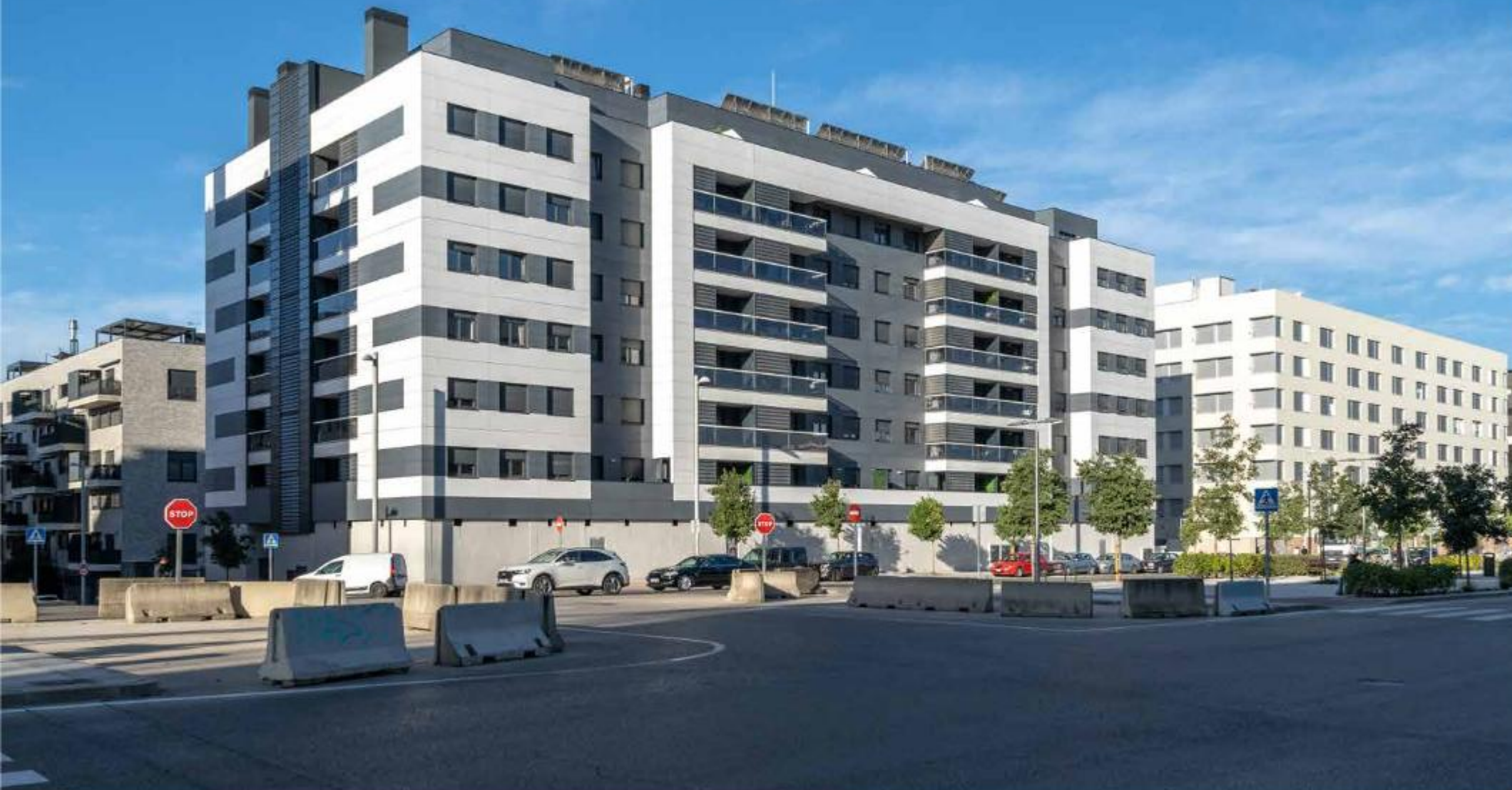
Fachada Lignum Tech, Proyecto Aedas Cañaverall
