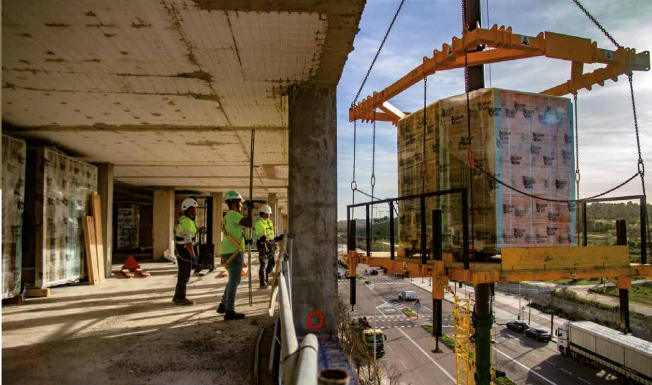
Baños Lignum Tech, Proyecto BTR VÍA ÁGORA - Aviva, Valdebebas
